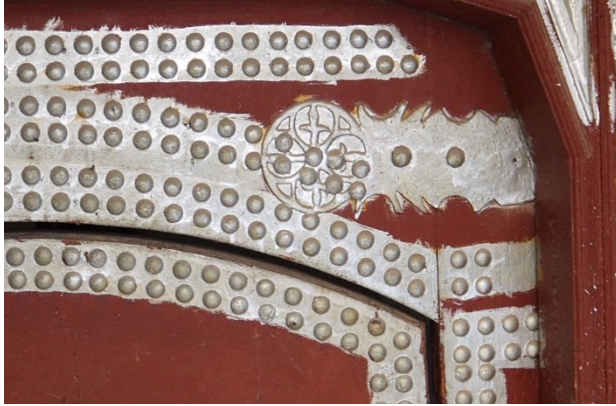
Abb. 3: Scharnier einer Haustüre in der Medina von Tetuan in Form eines Granatapfels. (Foto MD)
